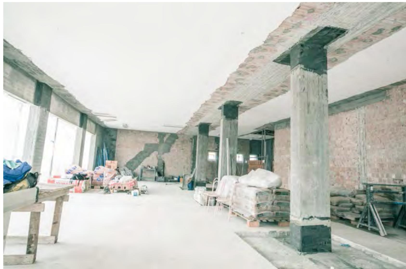
*ingrossamento dei pilastri perimetrali e placcaggio con fibre dei pilastri centrali*
