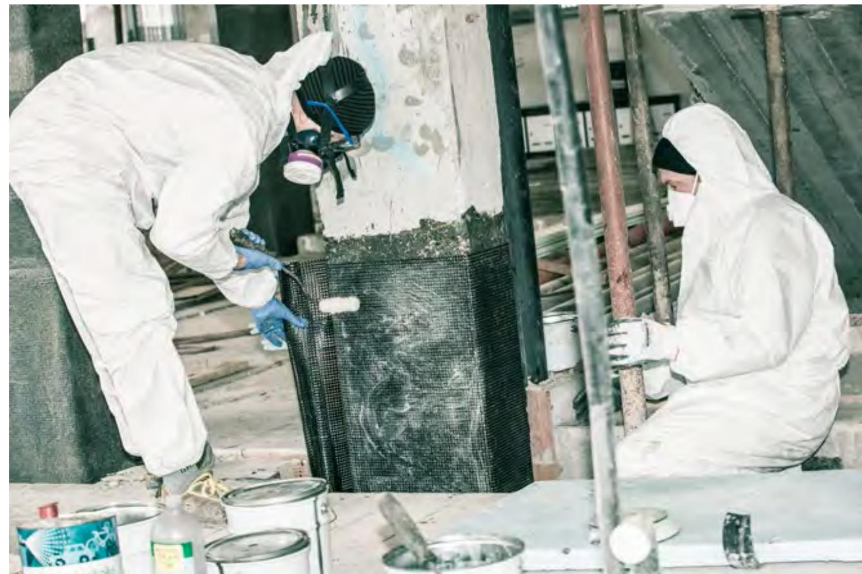
*placcaggio di pilastro con fibre in carbonio*
