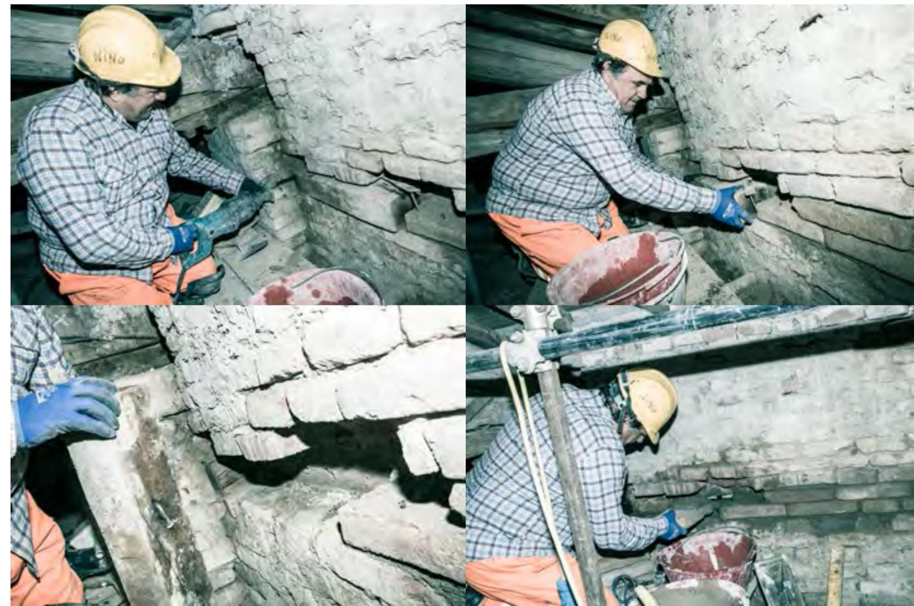
*rimozione del dormiente in legno e ripristino della muratura con tecnica a scuci-cuci*
