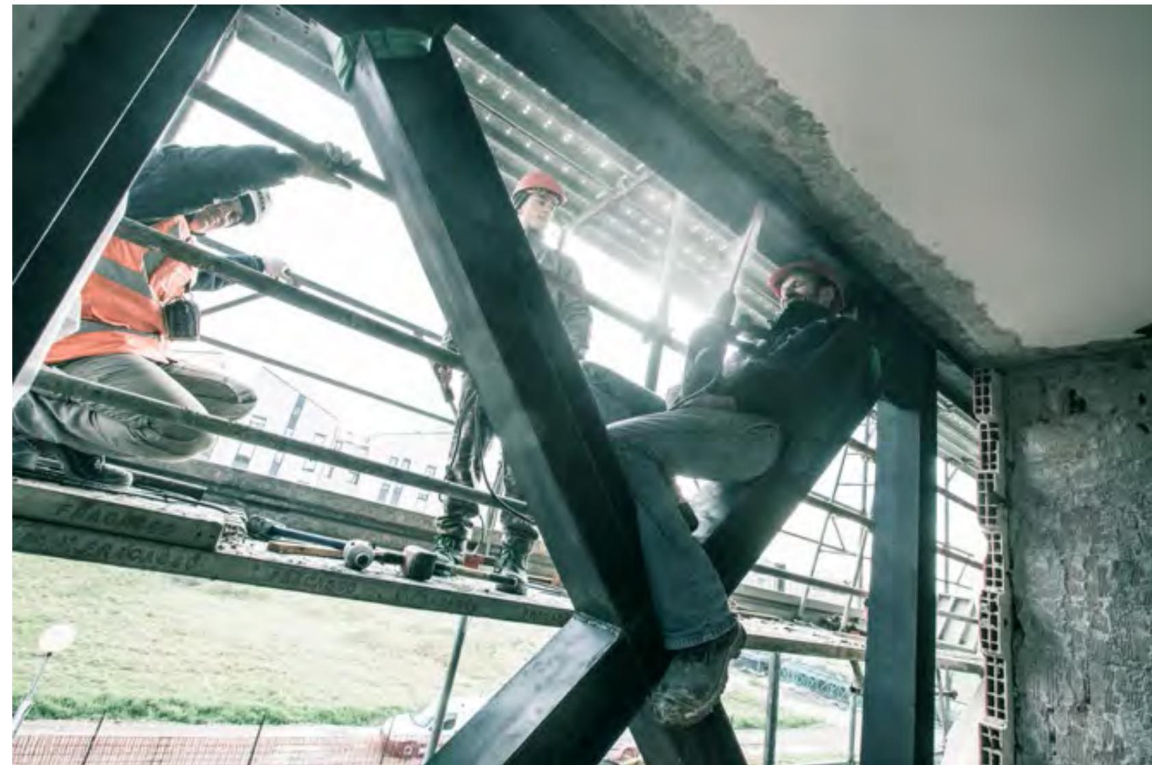
*portale metallico per consolidamento del telaio in cemento armato*
